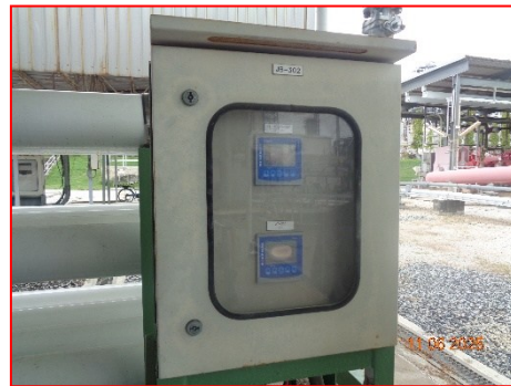
(26) Conductivity Online Analyzer บริเวณระบบ RO
