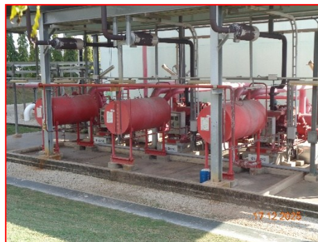
(61) เครื่องสูบน้ำดับเพลิง
