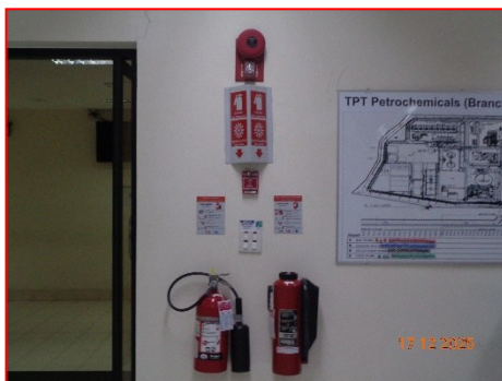
(55) Fire Extinguisher ชนิด ABC Dry Chemical และชนิด CO 2
